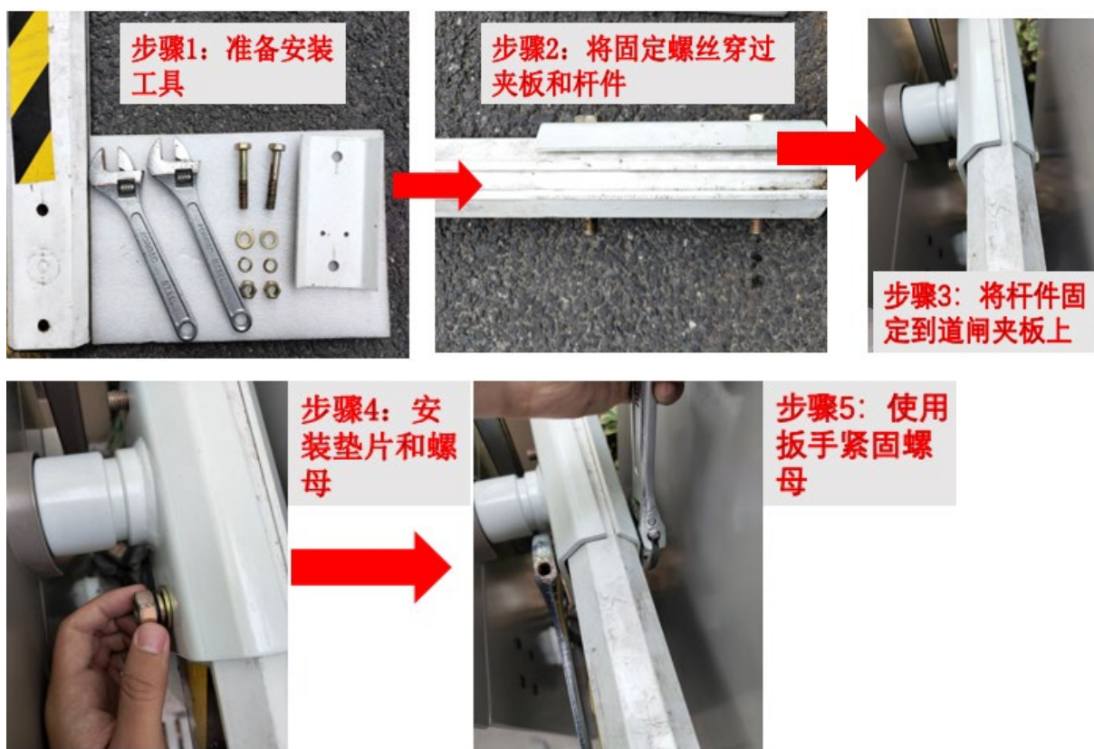
图3-5 曲臂杆主杆安装步骤
