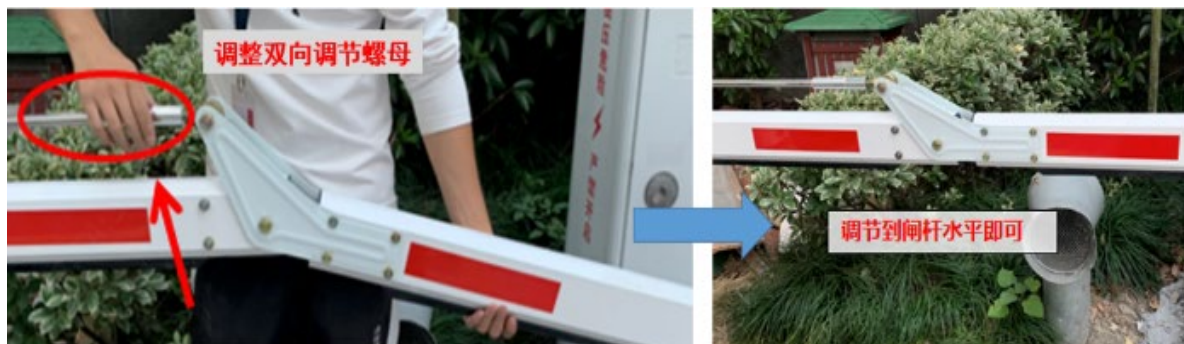
图3-7 曲臂杆平衡调节步骤
