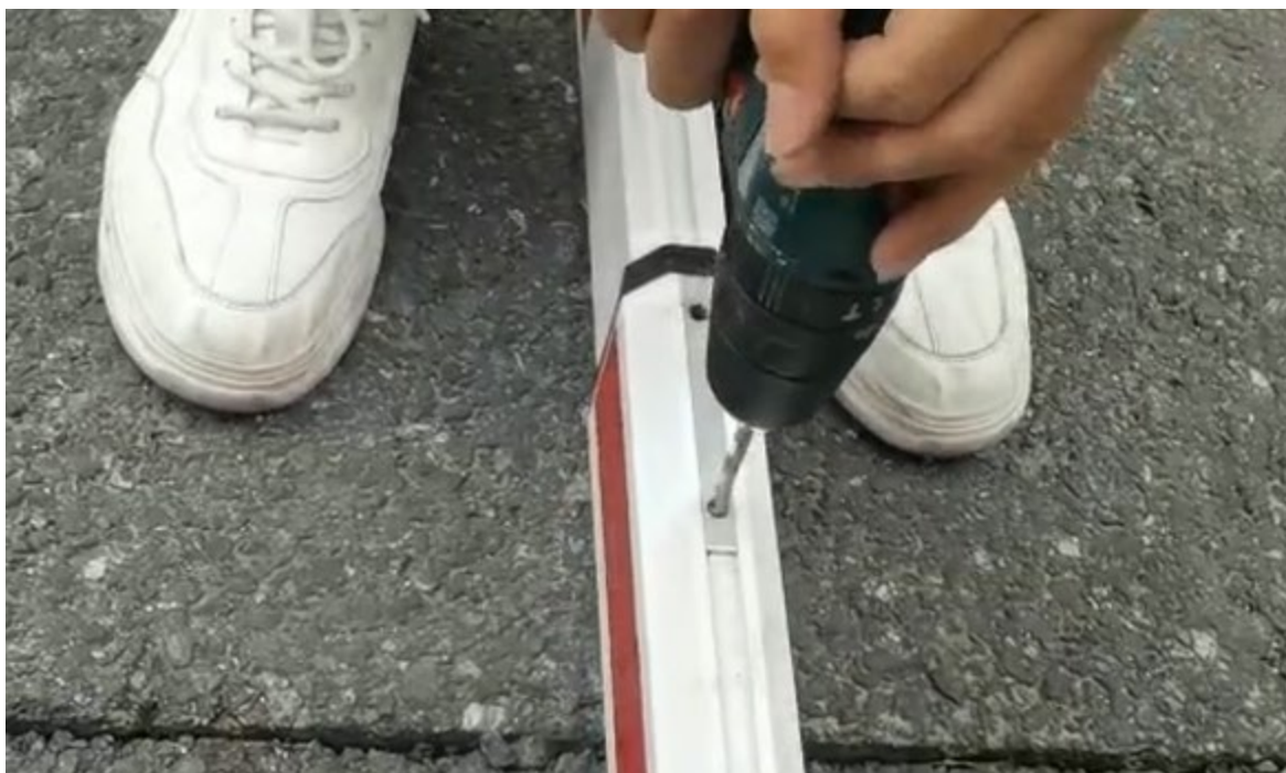
图3-12 杆件打孔示意图
